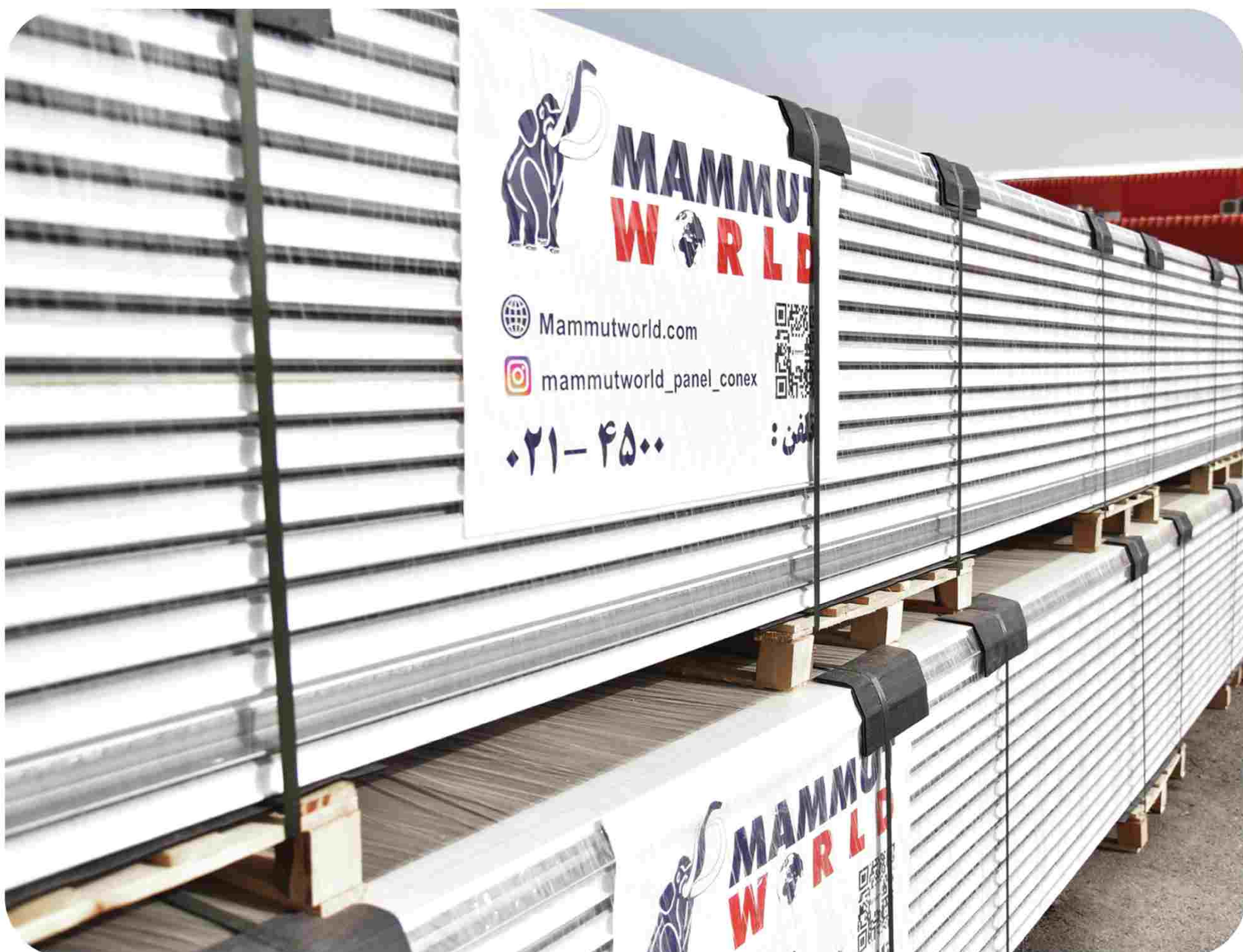
چیدمان بسته های ساندویچ پانل به صورتی باشد که گردش هوا به سهولت انجام پذیرد و از حبس هوا در بین بسته ها که باعث ایجاد رطوبت می گردد جلوگیری به عمل آید.
