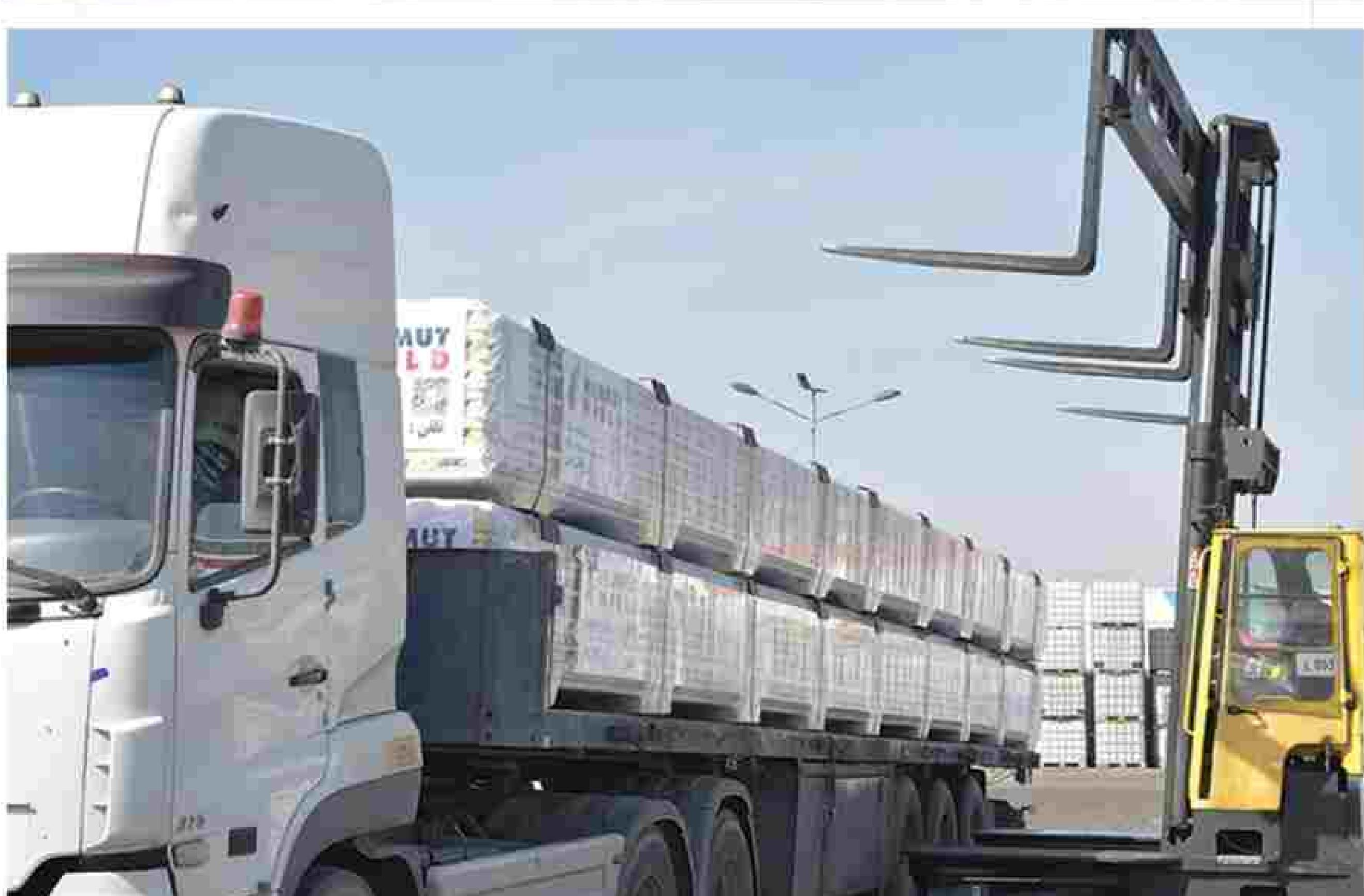
در صورتی که طول بسته های ساندویچ پانل بیش از ۶ متر باشد از لیفتراک بغل دار یا جرثقیل تلسکوپی که به شاهین (اهرم حمل بار) مجهز شده است استفاده صورت پذیرد.
